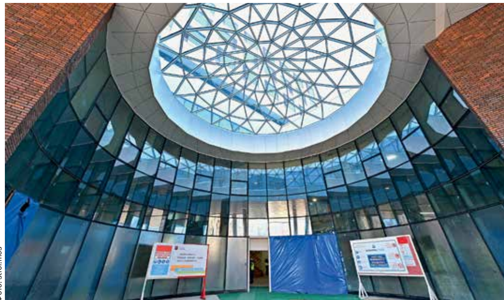
▲ При проектировании здания были использованы сложные архитектурные решения
