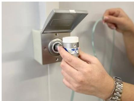
**Рисунок 3.** Подключение флоуметра к централизованному источнику кислорода
