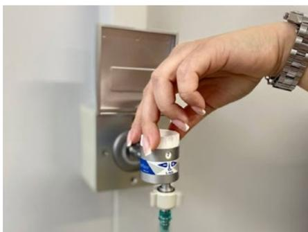
**Рисунок 4.** Регулятор флоуметра позволяет установить скорость потока  $O_2$
